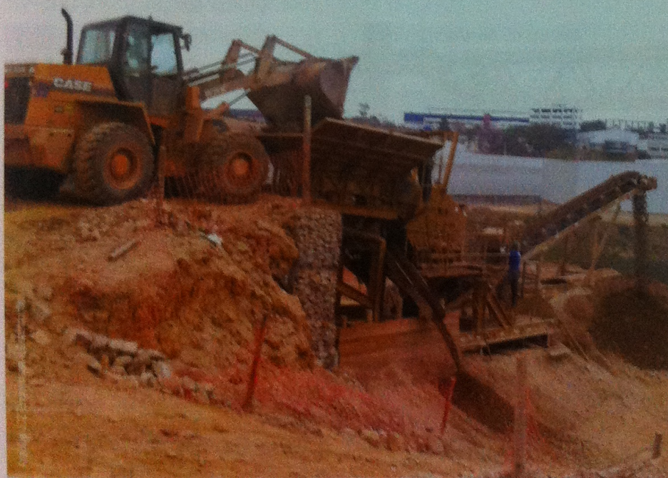
Resíduos de construção civil reciclados podem ser aproveitados em pisos
